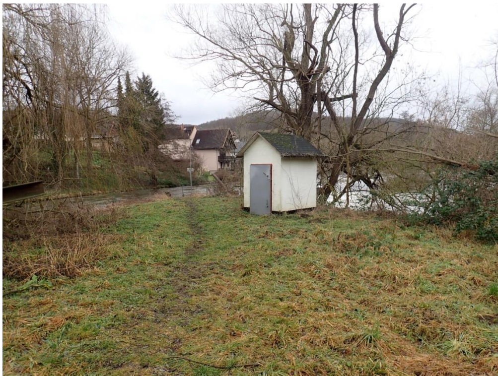
Abb. 10: rückzubauendes Bedienhäuschen mit Hydraulikanlage für die Wehrklappe und Standort des geplanten Restwasserkraftwerkes
