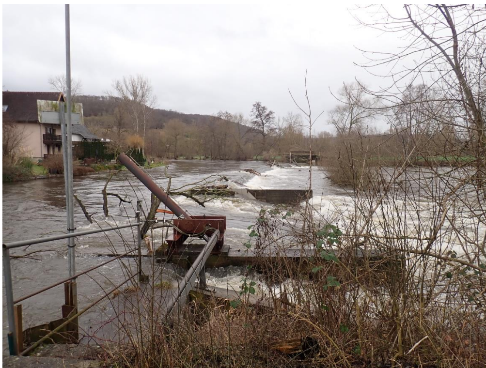
Abb. 6: Wehranlage mit Fischpass im Vordergrund
