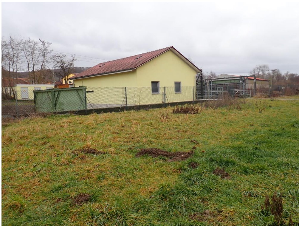
Abb. 11: Maulwurfshügel im Bereich des Hauptkraftwerkes
